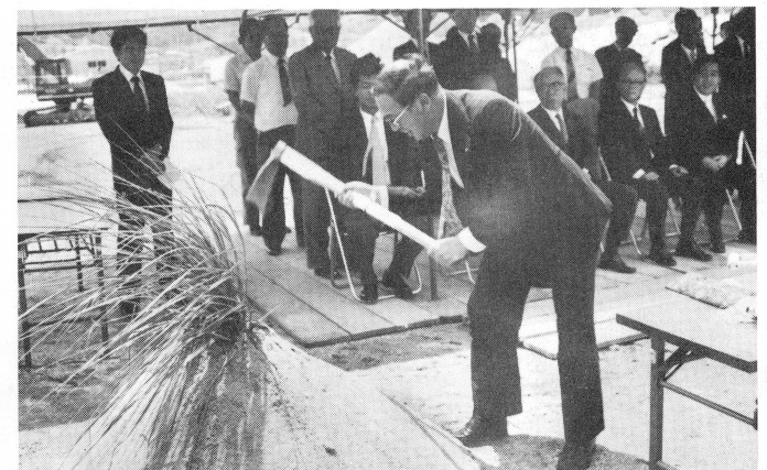
校舎建築工事起工式を挙。現地での神事に続きシルクホテルで祝賀会を開催。本体工事請負=勝間田建設㈱、設計管理=竹村建築設計事務所。(61.7.18)
