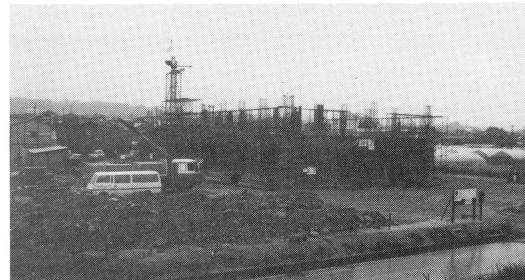
急ピッチで進められる建築工事。鉄筋コンクリート2階建て校舎(延1322㎡)のお目見えも間近。(61.9)
